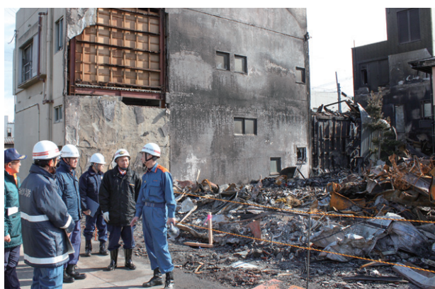
火災現場を視察する原田総務副大臣（左側3番目）
