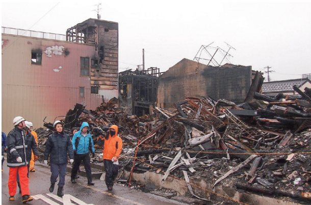
火災現場を視察する金子総務大臣政務官（左側2番目）
